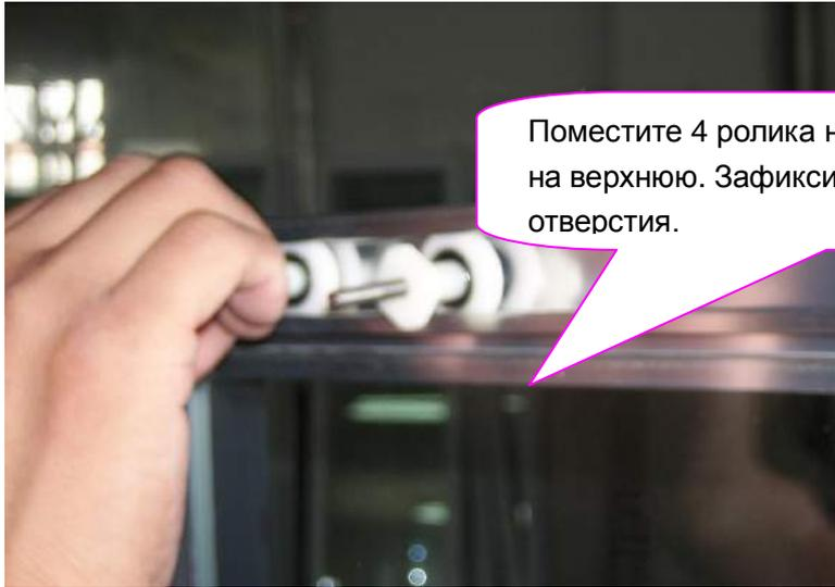
Поместите 4 ролика на нижнюю направляющую и 4 на верхнюю. Зафиксируйте дверь с роликами через отверстия.
