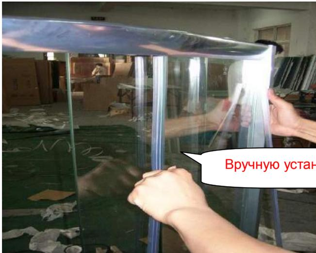
Вручную установите уплотнитель с двухсторон стекла.
