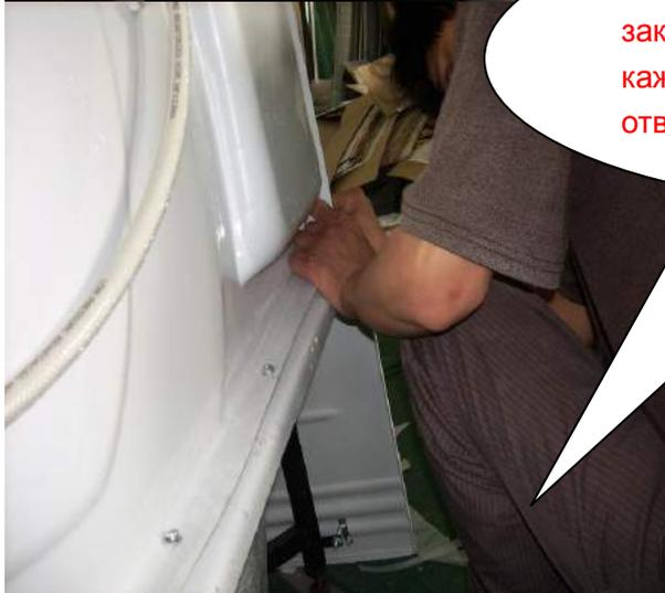
Отверстия: задняя панель имеет закругленную форму, поэтому с каждой стороны имеются по 3 отверстия для шурупов.
